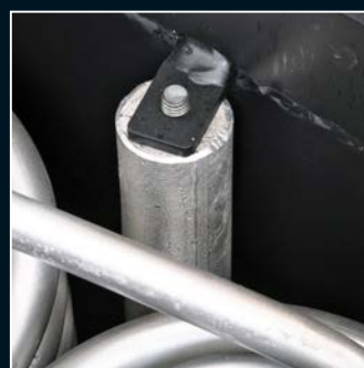
Magnesium-Schutzanode zum Schutz des Heizkessels
